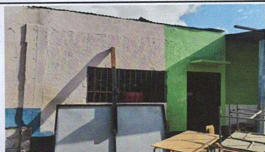
Foto 5: Las paredes requieren un repello y cernido para alcanzar un acabado uniforme en su superficie.
