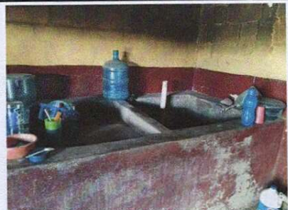
Foto 4: Reparación de pila existente de concreto, la cual es de gran capacidad pero se ha rajado y no almacena el agua por lo que se requiere reparación de pila para almacenar 1 m3 aprox.
